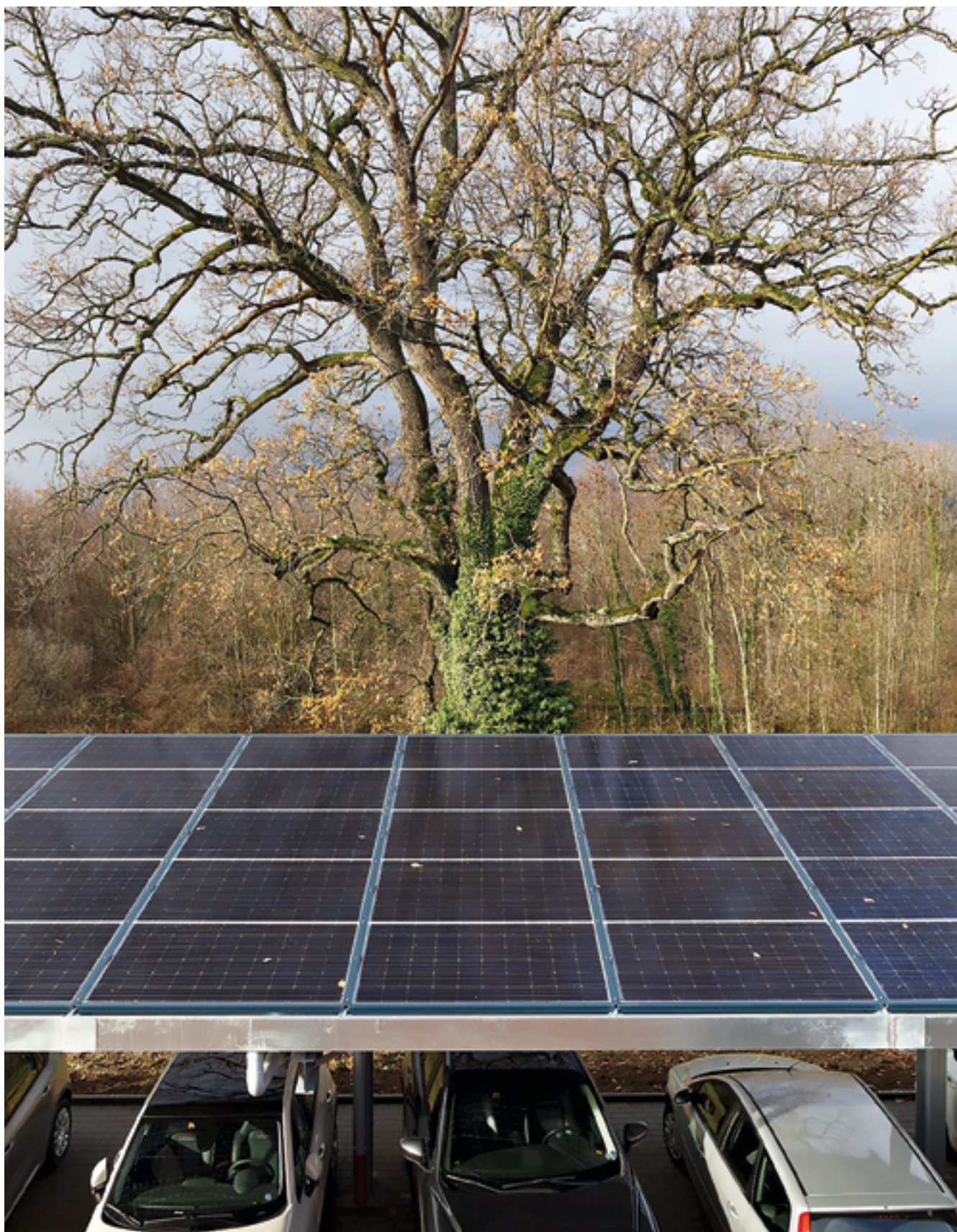
Une centrale solaire participative a également été installée sur le toit de la cafétéria du site de Cheseaux
