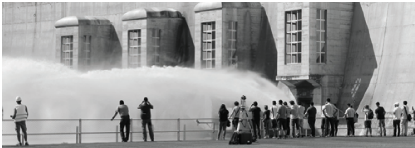
Travail de terrain sur le barrage de Schiffenen (FR) pour les étudiant-e-s de 2 e année de la filière Bachelor Géomatique
