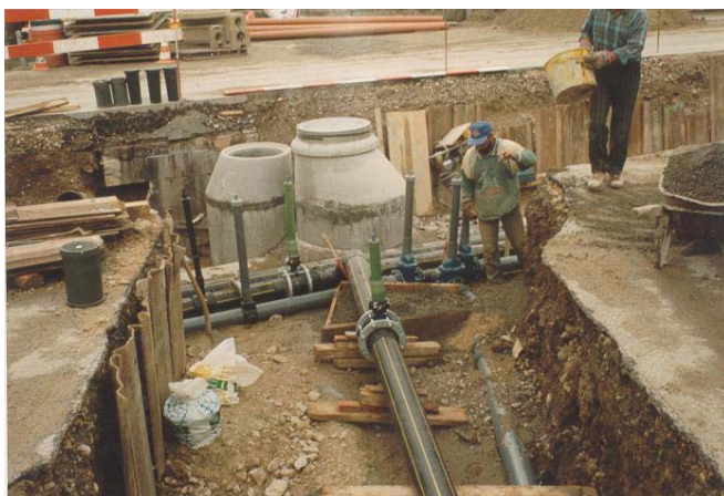
Travaux de mise en séparatif
