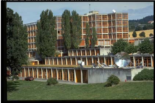
Vue sur les bâtiments de l'EIVD, objet du projet
